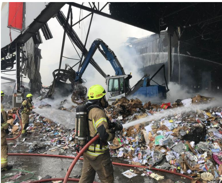
Foto: Oslo brann- og redningsetat, v/ Lars Magne Hovtun, anlegg i Oslo
